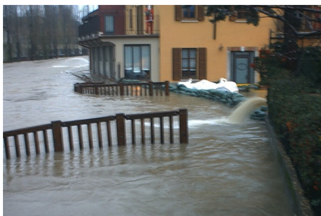
Foto – livelli fiume Lambro durante la piena 26/11/2002 (ore 16.00 al punto di massima portata). Notare la rottura del muro di cinta della ditta Caprotti in Comune di Albiate. A seguito di tale danno anche le tubazioni del gas furono rifatte e il loro livello nei pressi del ponte innalzato.
