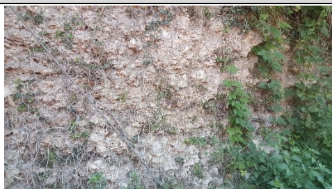
Versanti di via Viganò ingabbiati con reti paramassi
